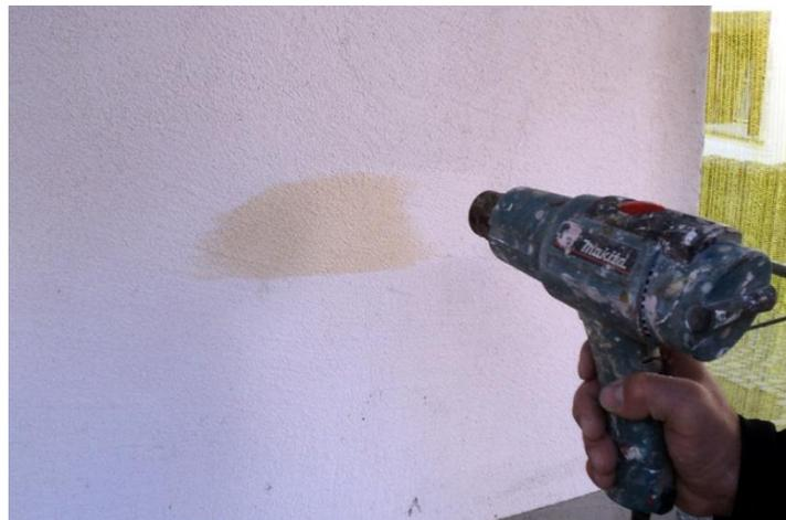
Das Weiss des Sumpfkalkes ist zu hell und wird mit der Beigabe von wenig Ocker-Farbe abgetönt.
