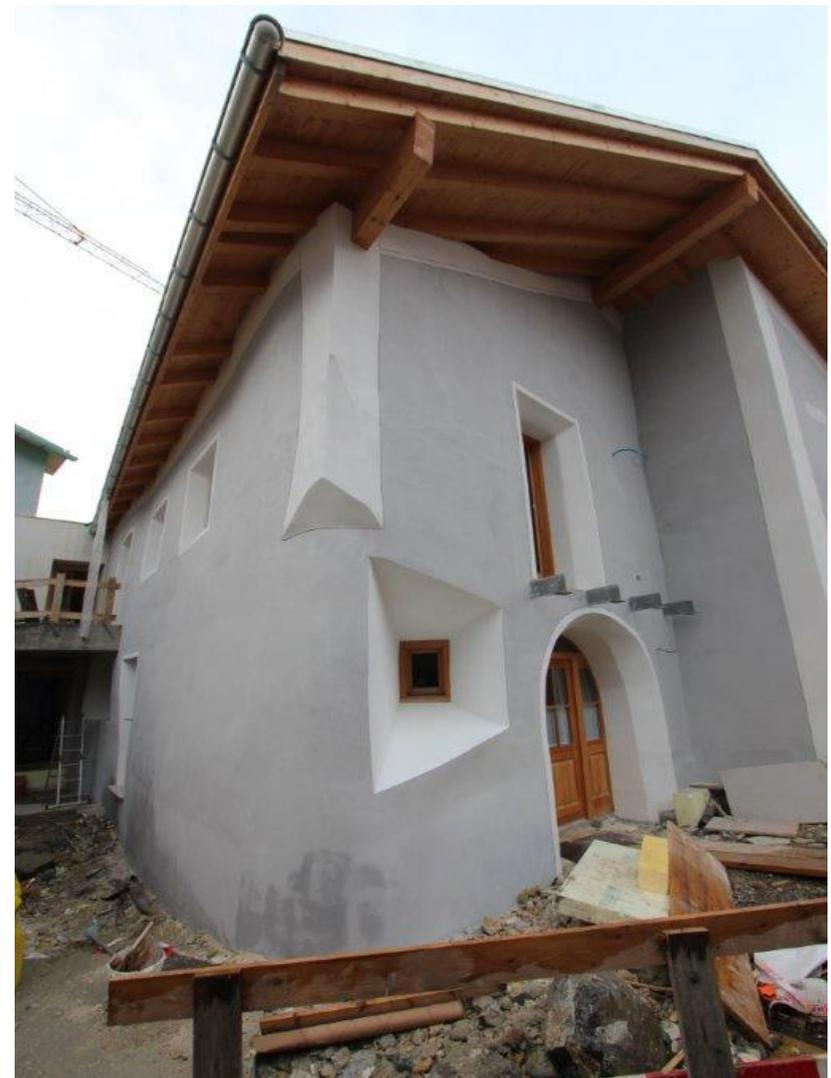
Das kleine Fenster links neben dem Rundbogen (Bild links) wurde trichterartig geöffnet (Bild rechts).
